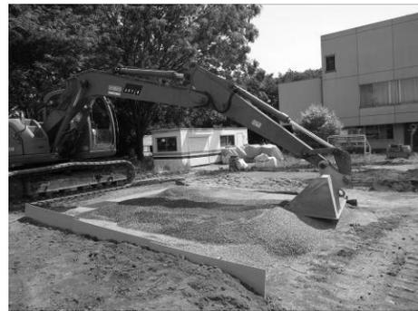
b. 法面バケットによる礫材の敷き均し
