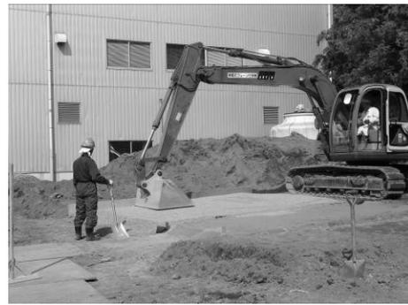
a. 法面バケットによる礫層の締め固め
