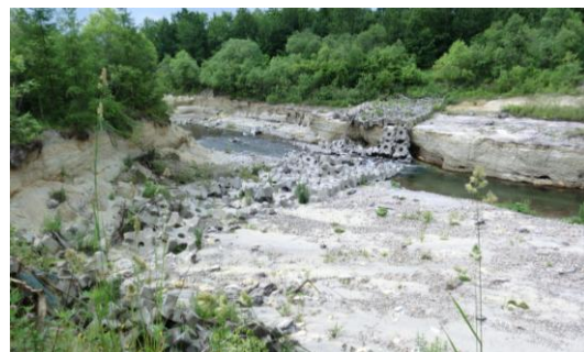
写真-2 然別川 万年頭首工より1km程度下流付近 (2013年6月26日撮影)
