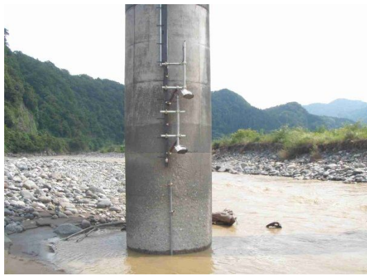
図-2 姫川山本観測地点の水道橋に設置した観測機材
