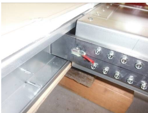
(c) 垂壁接合部補強材の設置状況
