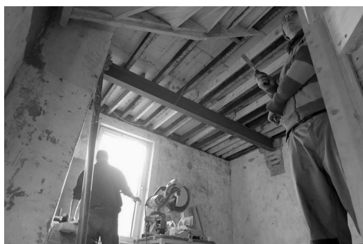
写真 1 指導員(左)のそばで作業する実習生(Hill Holt Wood による空き家改修現場)
