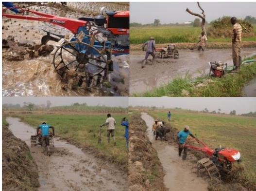
図4. 耕耘機のプラウは人力では重労働になる比較的大きい水路の切削と畦畔作りに威力を発揮する。又、レバラーは液状化と水路を利用すると数10m以上の距離の土移動が可能になり、ブルドーザーやバックホー等の重機の代用にもなる。左上はArugunu氾濫原。それ以外はBidaのKaduna川のEdozhigi氾濫原のWoya付近。
