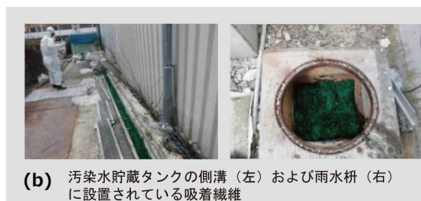
図5 東電福島第一原発で実用となっているセシウム除去用吸着繊維
