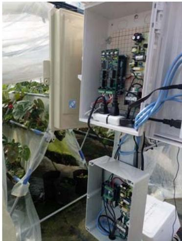
図6 低コスト二層カーテン制御システムの設置状況
