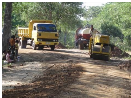
図3 路盤・表層工の様子（事業B、C）
