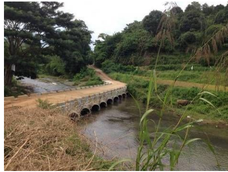
図7 建設されたカルバート(パイプ)付帯型沈下橋の雨季(2015年9月)の様子
