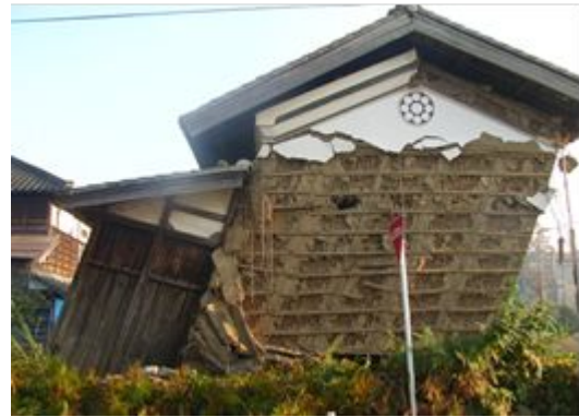
写真1 地震後傾いたまま立っている土蔵
