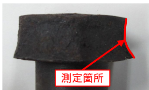
(a) 計測対象ボルト頭部
