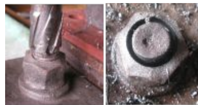
(a) コア抜き作業 (b) コア抜き後 写真-2 コア抜き法
