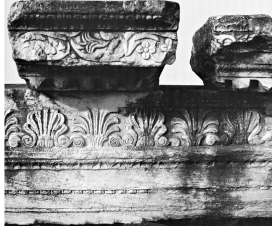
図7 コリントの「捕虜のファサード」1階のエンタブラチュア
