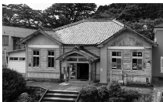
図4 旧伊深村役場外観
