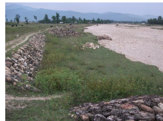
図-2 河岸侵食対策箇所—施工後 15 年：堤防と水制が機能している(上：1997 年 5 月, 下：2013 年 10 月)
