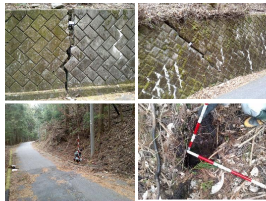
図4 虫川地区に見られる斜面変状
