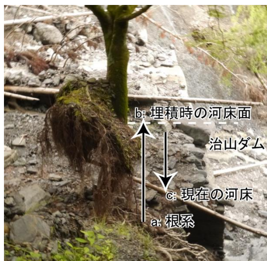
図8 口坂本地区の崩壊斜面の対岸に見られる河床変動の痕跡
