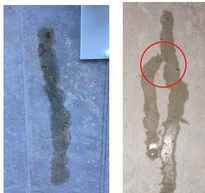
写真1 流水ガイドを用いない場合
