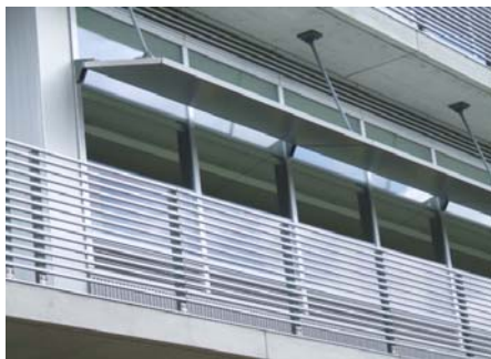
写真1 外装部材(庇等)の例
