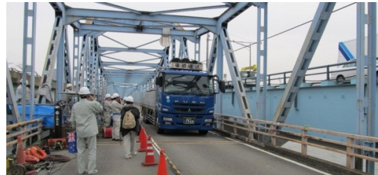
図2 実橋梁実験の様子。斜材破断側には作業スペースが有るため、逆車線側を車両は走行した。
