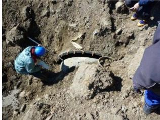
写真1 地震により生じた継手の離脱
