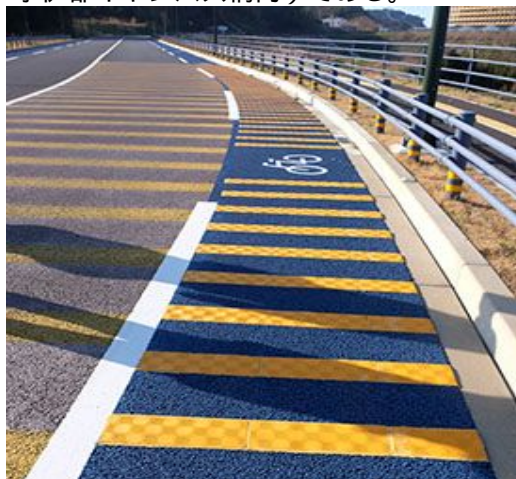
図7：傾斜型路面マーキングシート施工現場（九州大学伊都キャンパス構内）
