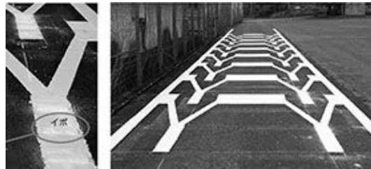
図5：ジグザグ形式イメージハンプ(タイプ2)の施工(崇城大学オレンジ球場前)
