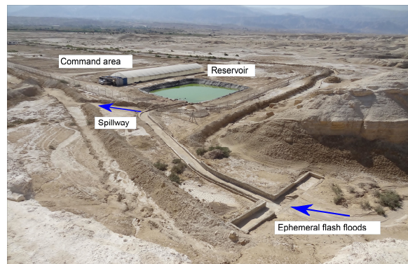
図1：構築した自律分散型灌漑スキーム
