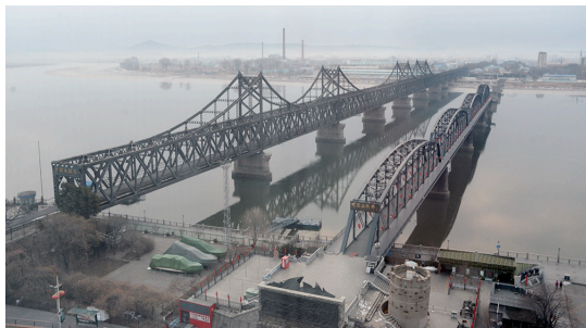
図 12 : 第三種耐弾構造である鴨緑江橋梁 (左が耐弾構造, 右は従来型単純トラス橋)
