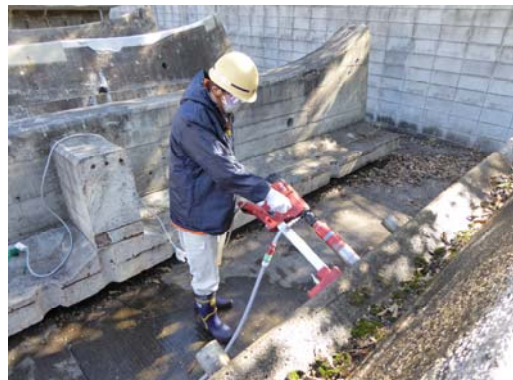
写真) 撤去済みの鉄筋コンクリート桁から鉄筋ごとコアを採取している様子
