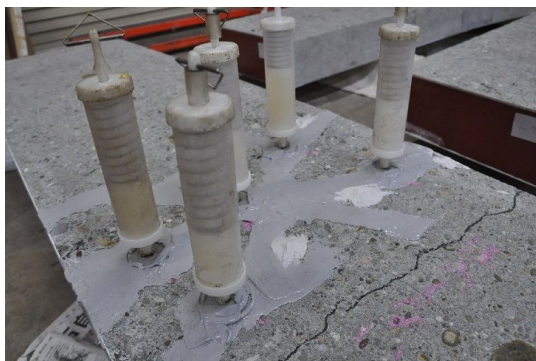
写真 - 3 ひび割れ注入状況
