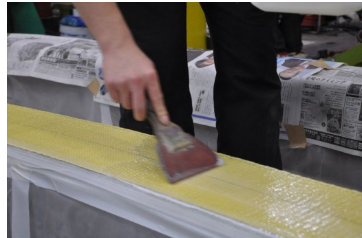
写真 - 4 シート接着状況
