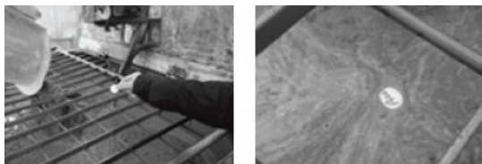
（コンクリートへのICタグ投入）
