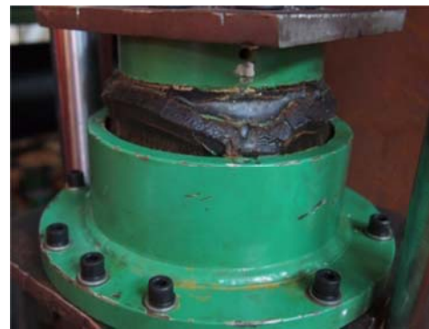
ダンパー損傷後
