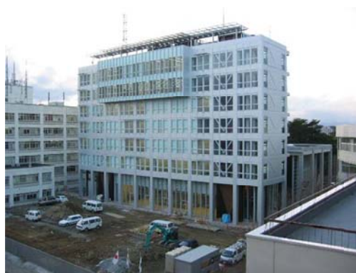
対象建物全景（鉄骨造8階建）
