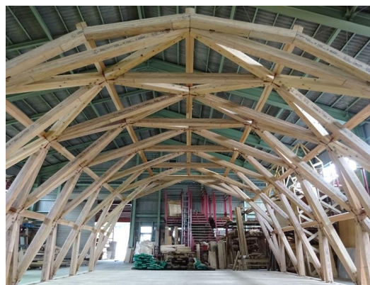
写真4 6mスパン改良型ヴォールト構造
