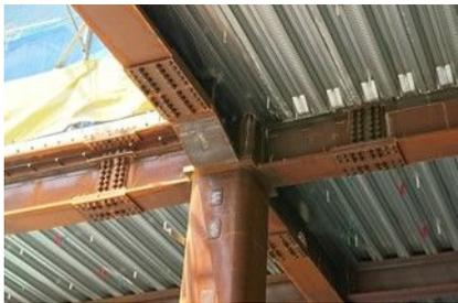
図1 日本式の鉄骨ラーメン構造
