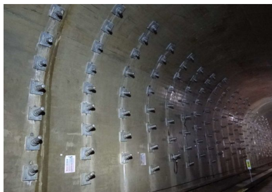
写真4 白岩堰堤右岸側岩盤補強のアンカーとケーブルボルト
