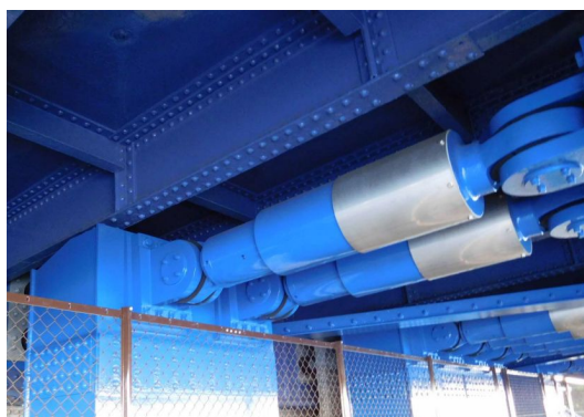
写真2 清洲橋に設置されたダンパー
