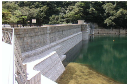
写真1 補強された布引水源地五本松堰堤
