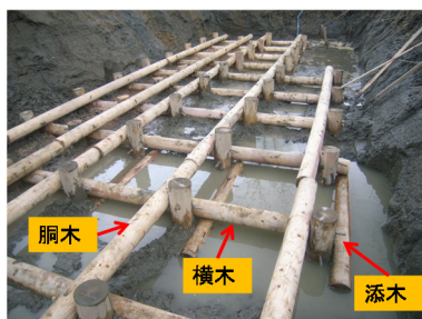
図3 木杭基礎の構造
