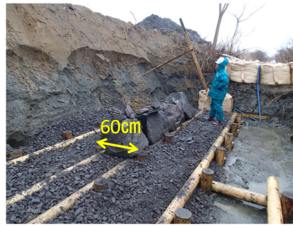
図4 石積みの施工
