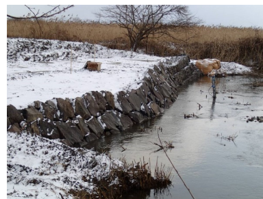
図5 完成した水路護岸 (手前：石積み、奥：フトン籠)
