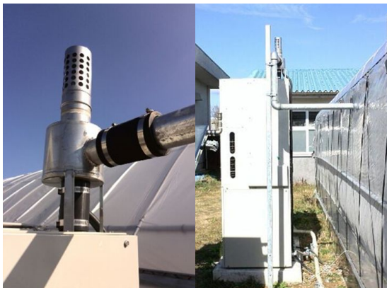
図3 GHP 排ガス分岐部とGHP 室外機からの排ガス導入状況
