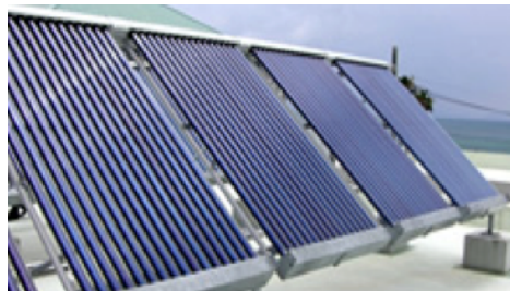
図4 太陽集熱パイプの設置風景
