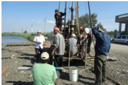
ボーリング状況
