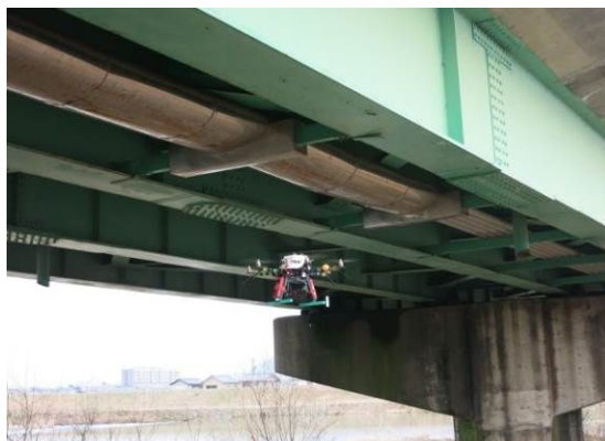
図 4 橋梁下面(桁や床版)の撮影の様子
