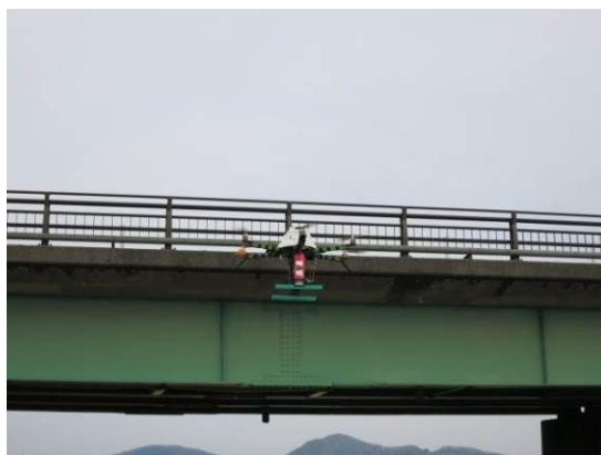
図 5 地覆や鋼桁の撮影の様子
