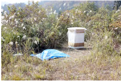
図 9 白山市白峰に設置したシステム (2015/9/30~10/31UT) 白いカバーの中にクライオスタットが、ブルーシートの下に FLL やデータロガー、バッテリーケースが設置してある。
