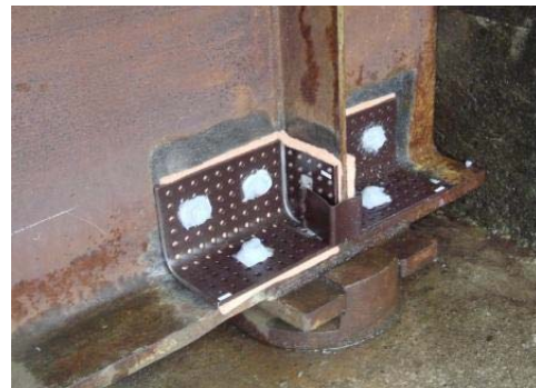
犠牲陽極板と繊維シートの設置状況
