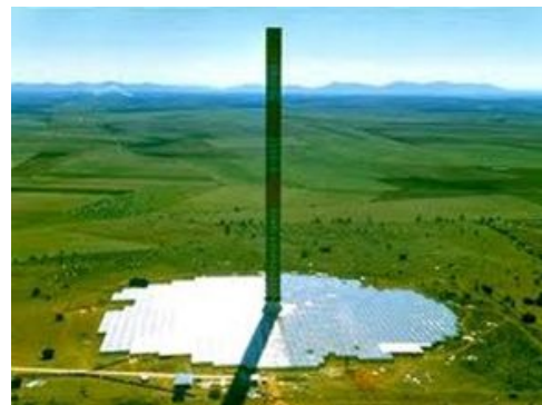
図2: Manzanaresにおける試験プラント
