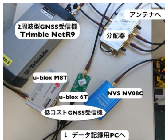
図2 研究室に設置しているGNSS機器
