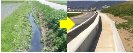
図-3 農業用水路の改変は、二枚貝の生息場所の物理環境を劇的に変化させる（水路勾配の上昇、粗度の低下、流速の増大、河床材料の喪失）。イシガイ類の分布を制限する最大の要因である。
