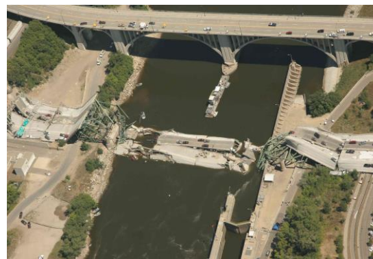
図-2 崩落したI-35W橋 3)
