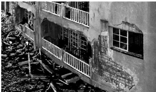
図1. 構造物劣化状況の3D計測結果の可視化例
