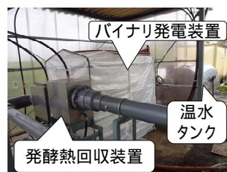
写真 1-2 バイナリ発電装置と発酵熱回収装置の設置状況
