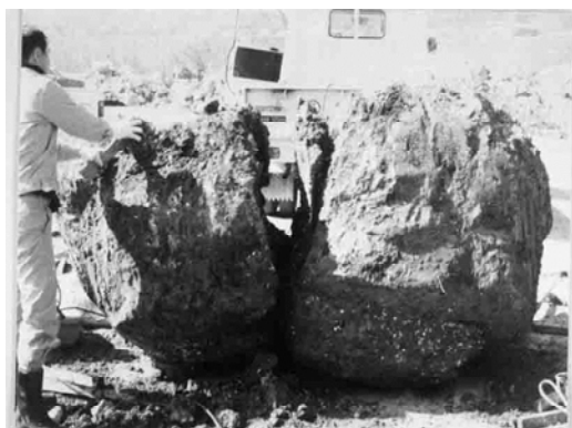
図9 埋設した原位置固化土
