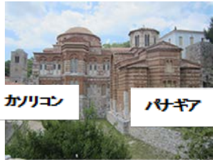
写真 4.1.1 オシオス・ルーカス修道院
