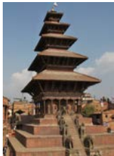
写真 4.4.1 ニャタポラ寺院五重塔
