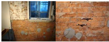
写真 4.8.1 ひび割れ変位のモニタリング
