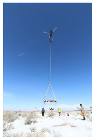
図 2 ヘリコプターによる SD の設置。予め地上で待っている部隊が SD を誘導している。
