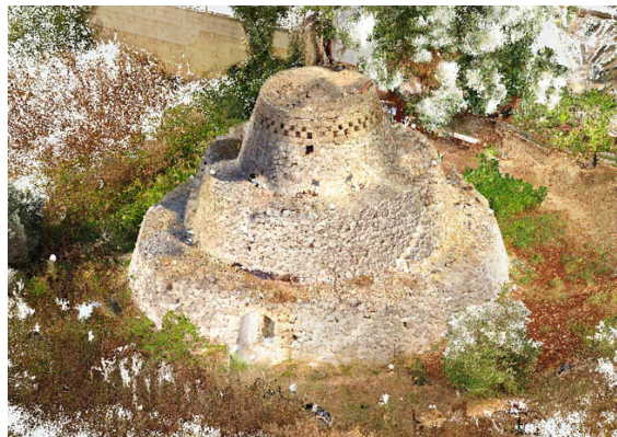
図2 3D点群データより作成したパイアーレ (図1) の俯瞰図
