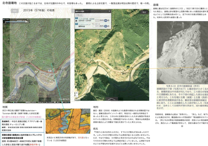
図6 昭和28年の有田川水害時の北寺地区の巨大山腹崩壊。下方にあった村役場を含めて、村の中心部が全滅した。
