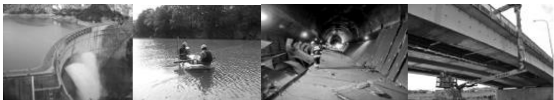
発電ダムの土砂堆積量調査
