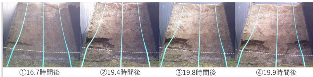
写真2 無対策盛土斜面の破壊状況
