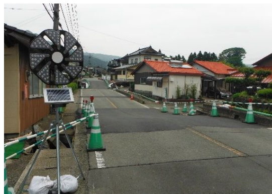
図2 狩尾地区の被害状況
